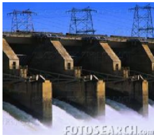
โรงไฟฟ้าและสถานีย่อย
