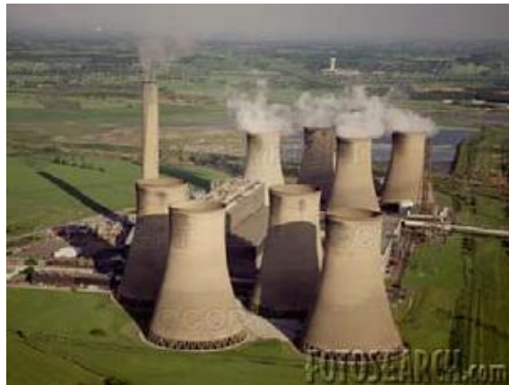
โรงไฟฟ้าและสถานีย่อย
