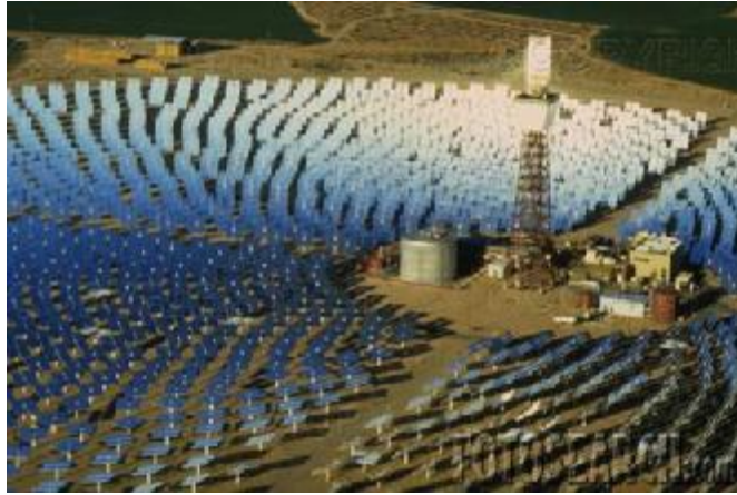
โรงไฟฟ้าและสถานีย่อย
