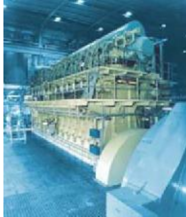
โรงไฟฟ้าและสถานีย่อย
