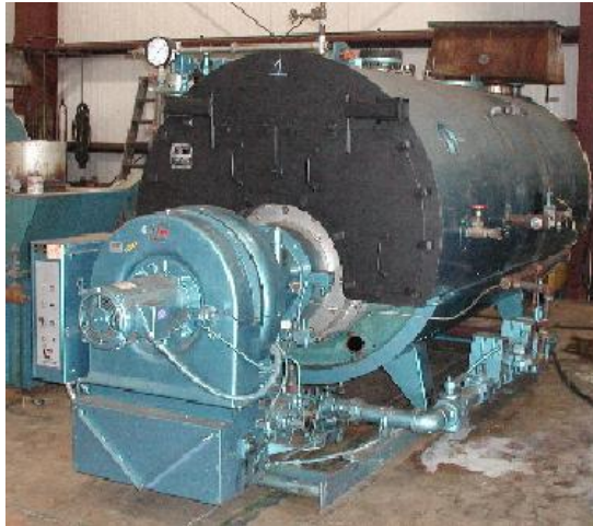
โรงไฟฟ้าและสถานีย่อย
