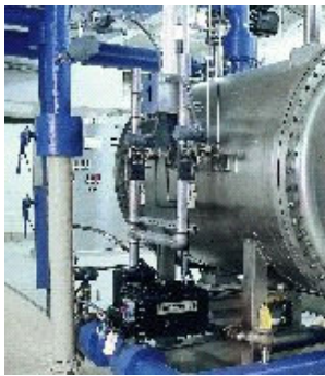
Figura 4: Equipo industrial para producción de ozono y difusores de burbuja fina para inyección del aire rico en ozono.
