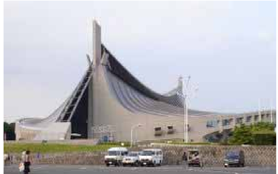
Gimnasio Yoyogi, de Kenzō Tange
