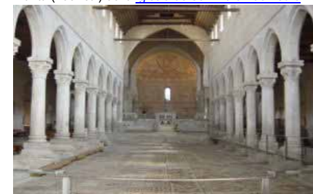
Basilica de Aquilea : Interior de Nave Central
