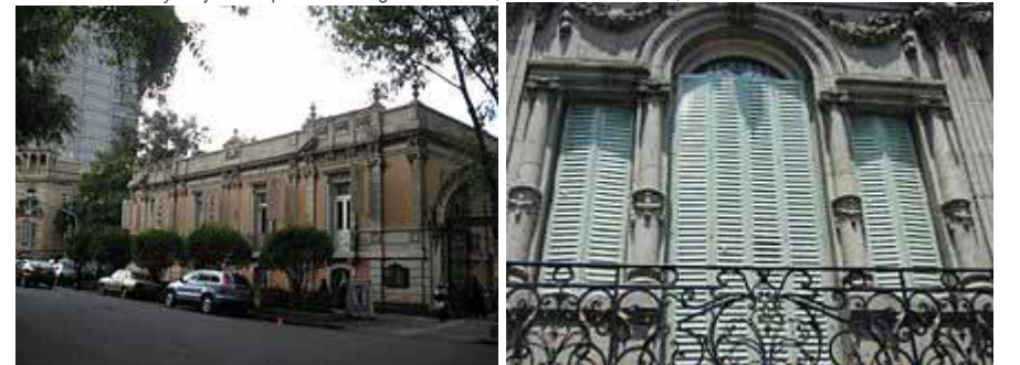
Casa "Lamm" (Exterior y Detalle); Colonia Roma; Ciudad de México
