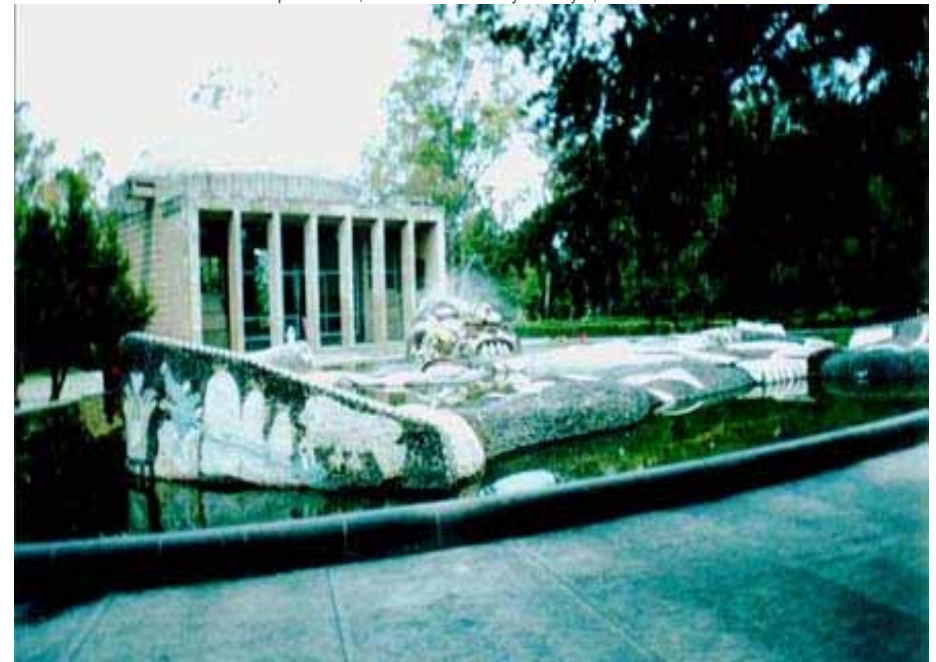
Cisterna del Sistema para Abastecimiento de Agua, A. Rivas Mercado; Ciudad de México (y Escultura de D. Rivera)
