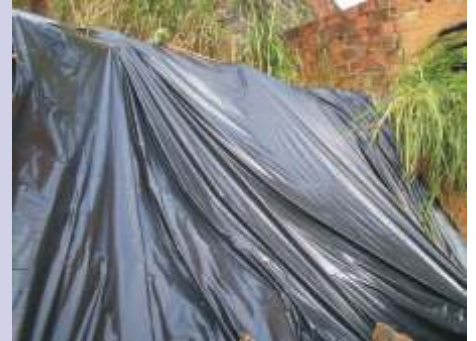
Encostas dos morros foram protegidas por lona plástica
