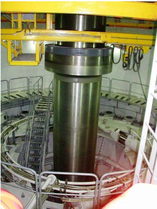
*Figura 2.27. Eje de conexión turbina-generador en una hidroeléctrica*
