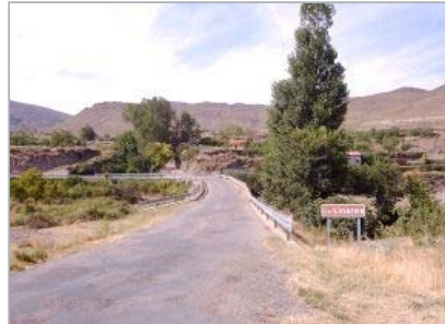
La actuación en Cornago prevé la construcción de un nuevo puente sobre el río Linares. / S. LOZA
