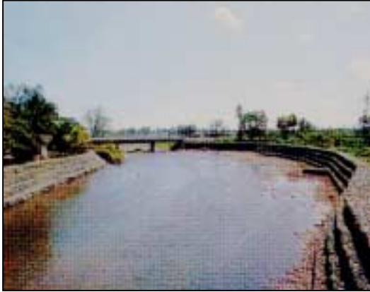
Protección con Gaviones
