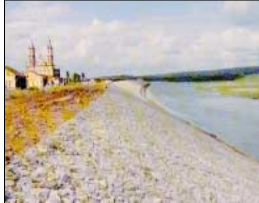
Protección con Colchonetas
