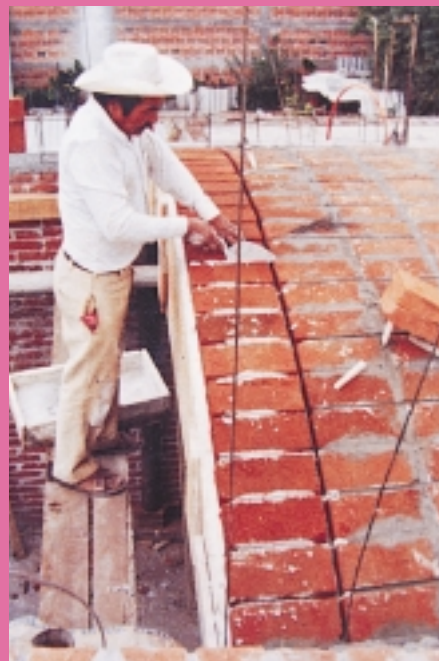
Casa Jaime Medina. Realizzazione della volta in laterizio armato su centina mobile.
