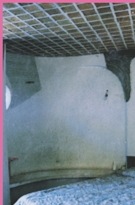
Interno della camera da letto della residenza dell'architetto. Il soffitto è in laterizio armato.
