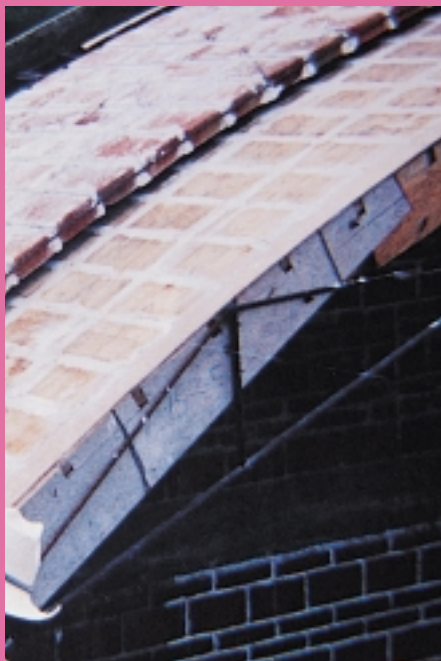
Cappella di San Pablo Coatlan. Momento dell'abbassamento della centina dopo aver realizzato la sezione di laterizio armato.
