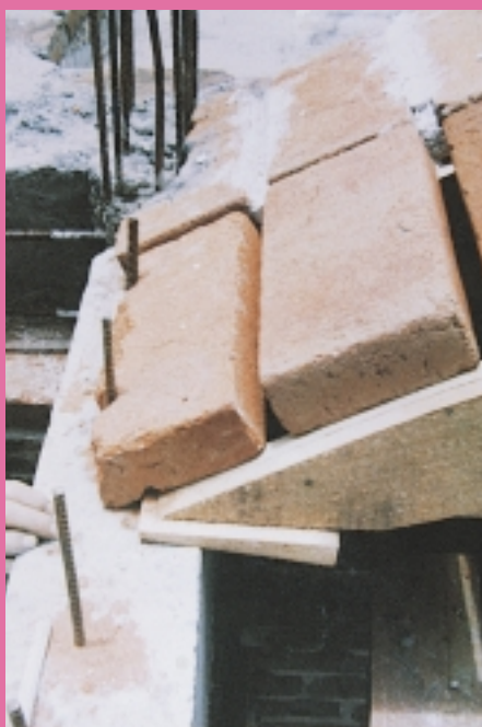
Dettaglio dell'incassatura nel muro nella catena laterale. Si osservi il piccolo cuneo di legno per poter abbassare la centina.
