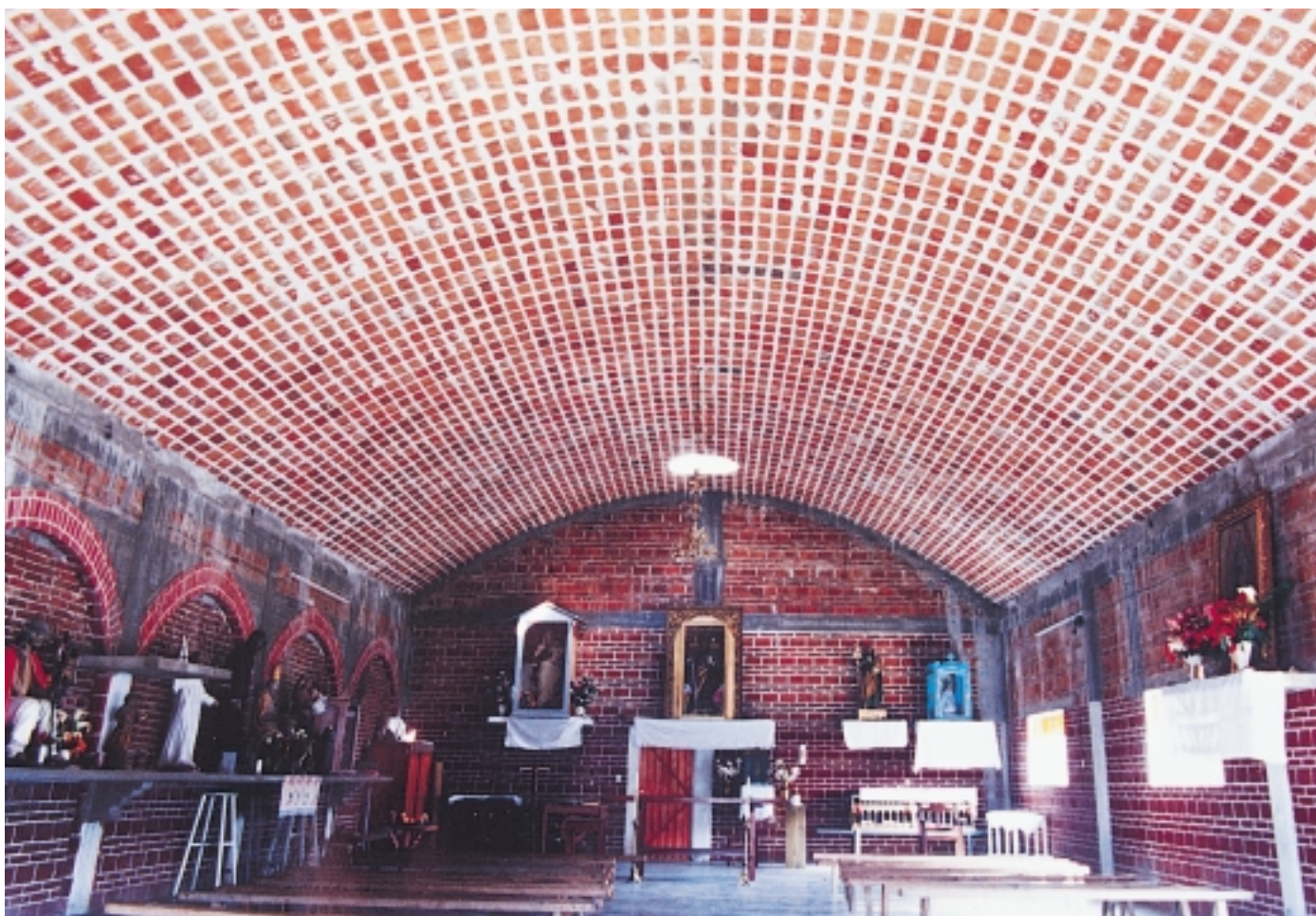
Cappella di San Pablo Coatlan. Vista interna verso la zona dell'altare.
