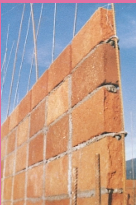
Casa Jaime Medina. Muro di laterizio armato.
