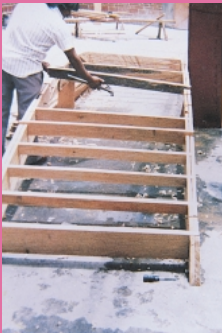
Cappella di San Pablo Coatlan. Lavorazione della centina in legno di 1,22x10 m.
