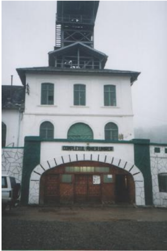
Acceso a la mina
