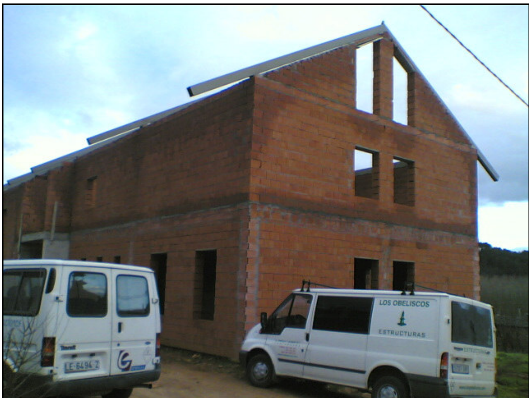
Las furgonetas que aparecen en la fotografía están trabajando en la obra de al lado
