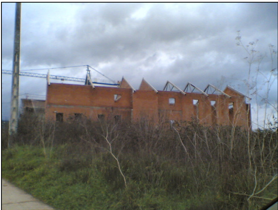
La grúa que se ve está trabajando en las Viviendas de Protección Oficial, al lado
