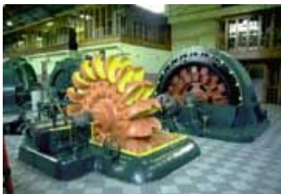
Pelton - máquinas de ação, altas quedas e baixas vazões
