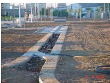
Vista del andén antes de la siembra del césped
