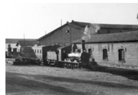
Vista lateral de la Estación de Jerez
