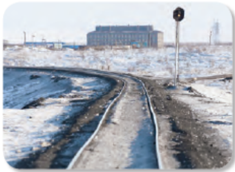
Figura 1.13 La dilatación térmica puede deformar las vías del ferrocarril y ocasionar accidentes.
