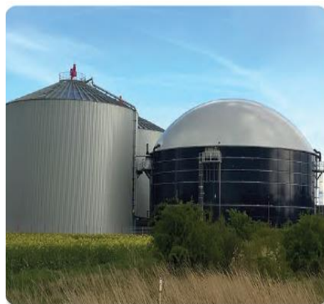
Figura 1.63 El metano producido en esta planta de biogás se obtiene de los procesos biológicos de degradación, por microorganismos, de la materia orgánica.
