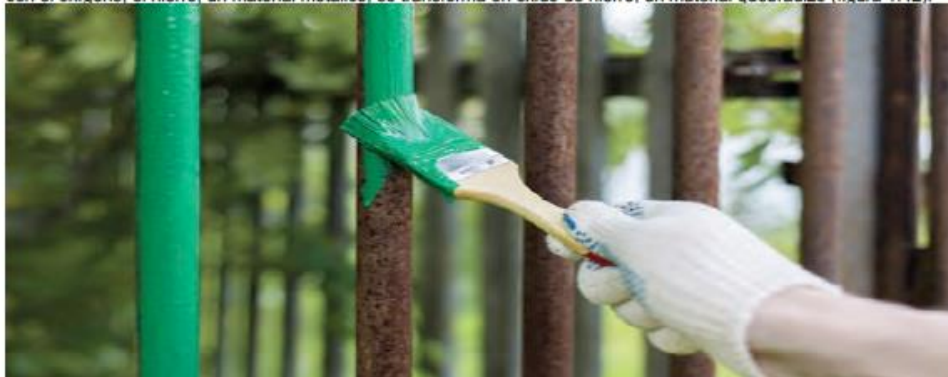
Figura 1.42 Para evitar el deterioro del hierro en estructuras de uso cotidiano, es necesario recubrirlo con materiales resistentes a la corrosión, como la pintura y el barniz.
