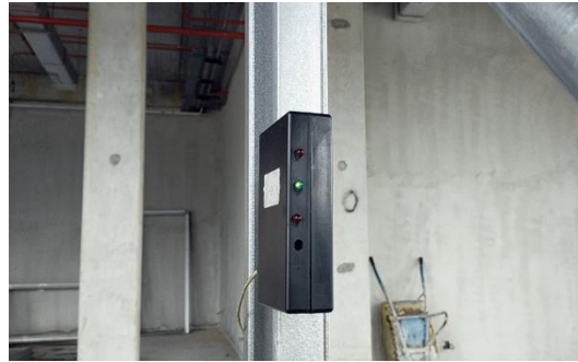
Rajah 5: LED hijau menyala pada ketiga-tiga sensor dan bunyi “buzzer” menunjukkan kerangka pintu atau tingkap telah didirikan dengan tegak
