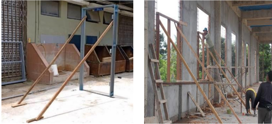
Rajah 1: Kaedah konvensional yang menggunakan kayu sebagai tupang
