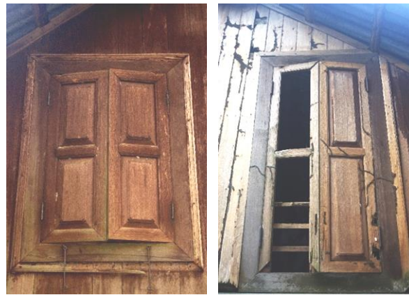
Gambar 4 Keadaan tingkap yang masih baik dan sebahagian telah reput
