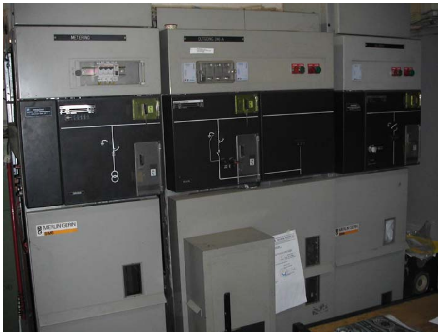
Gambar 14.14 Contoh Panel Cubicle di ruang Praktek POLBAN
