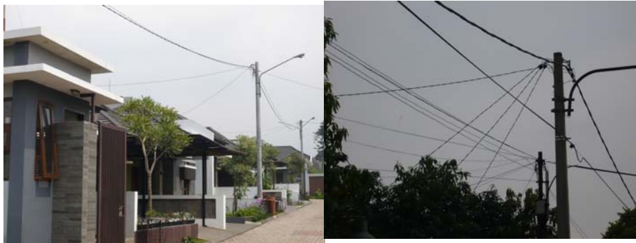
Gambar 14.5 Saluran penghantar udara untuk rumah tinggal (mengganggu keindahan pandangan)
