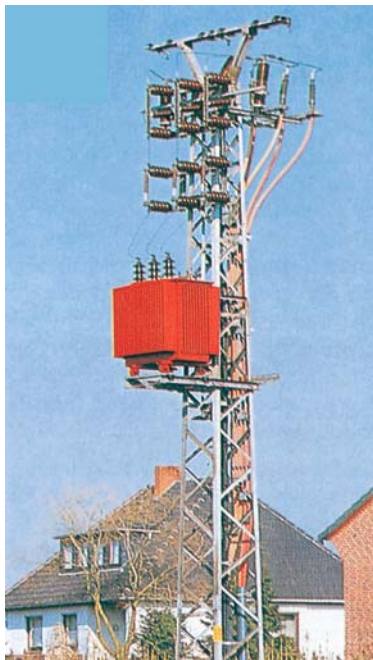
Gambar 4.44 : Pemasangan Trafo Outdoor
