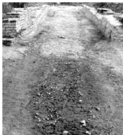
Lám. V: Puente de Miraflores. Pavimento de la rampa occidental. (Archivo Escuela Taller Miraflores).
