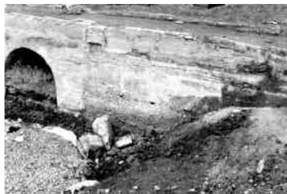
Lám. II: Puente de Miraflores. Cara sur de la rampa oriental. (Archivo Escuela Taller Miraflores).
