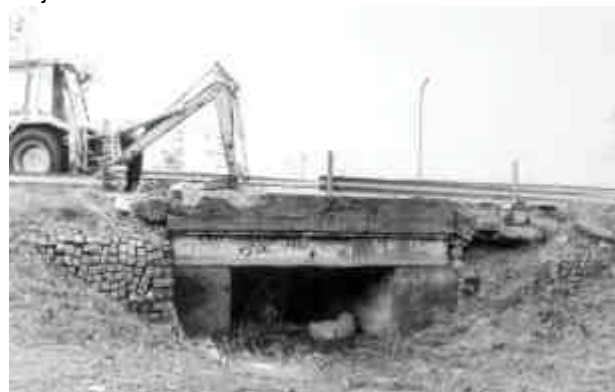
Lám. VII: Puente de Miraflores. Estado al comienzo de las obras. (Archivo Escuela Taller Miraflores).
