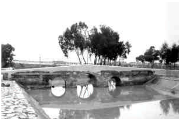
Lám. VIII: Puente de Miraflores. Fase VI, estado tras la rehabilitación. (Archivo Escuela Taller Miraflores).
