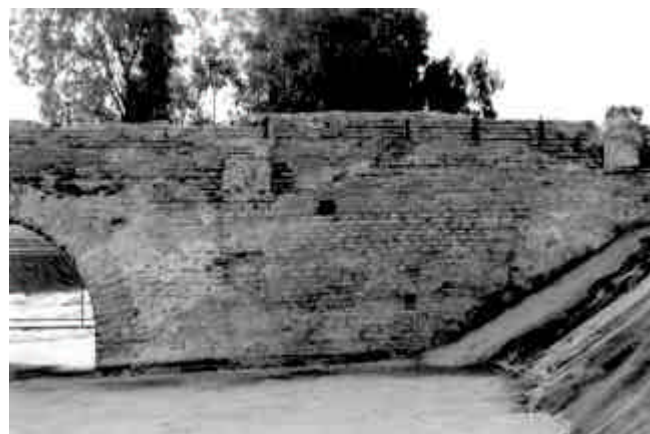
Lám. IV: Puente de Miraflores. Cara norte de la rampa occidental. Reconstrucción del muro (ue 82). (Archivo Escuela Taller Miraflores).
